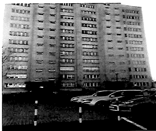
Fot. 12_Budynek wielorodzinny 2 klatki nr 3b i 3c
