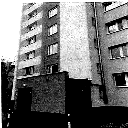
Fot. 2_Strefa wejściowa - klatka nr 2
