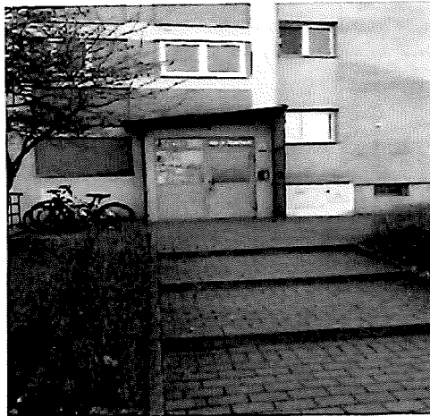
Fot. 4_Strefa wejściowa klatka nr 50
