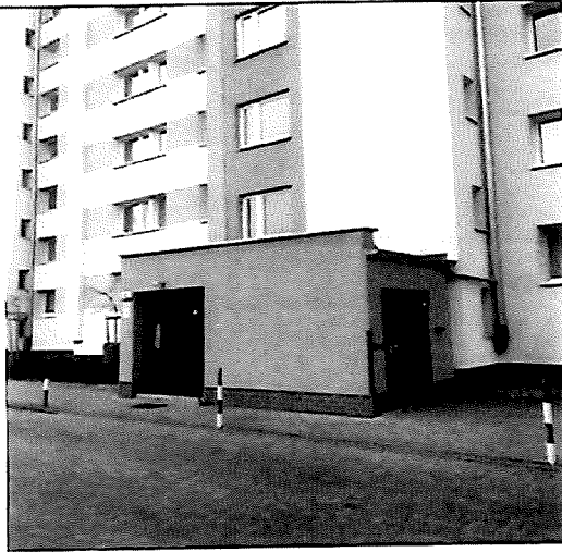
Fot. 4_Strefa wejściowa klatka nr 6
