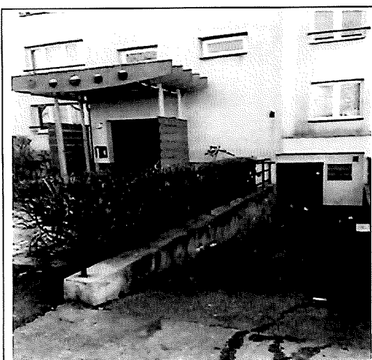
Fot. 8_Strefa wejściowa klatka nr 62
