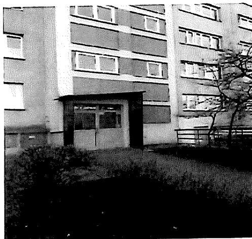
Fot. 3_Strefa wejściowa klatka nr 48
