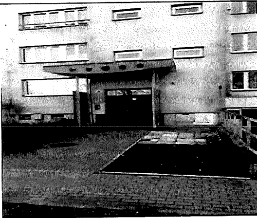
Fot. 13_Strefa wejściowa klatka 3b
