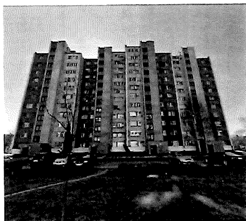
Fot. 1_ Budynek wielorodzinny 4 klatki nr 15-21
