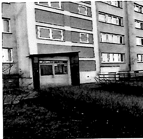
Fot. 2_Strefa wejściowa klatka nr 42
