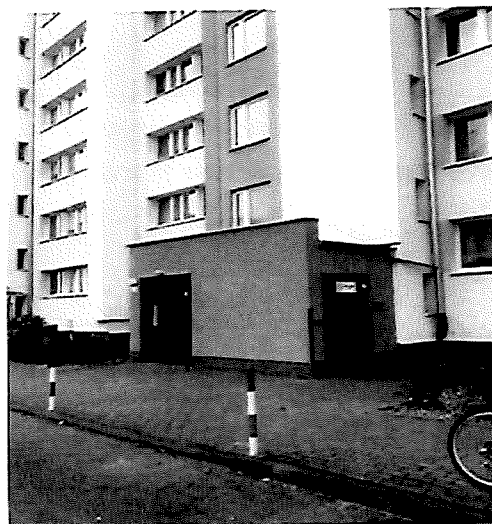
Fot. 3_Strefa wejściowa klatka nr 4
