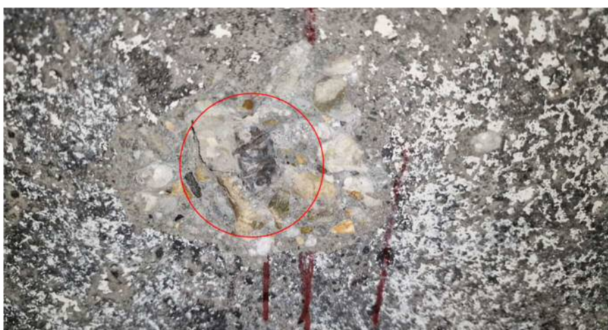
Fot. 45. Powierzchnia pręta w odkrywce betonu (w kółku) w okolicach punktu P3 bez śladów korozji
