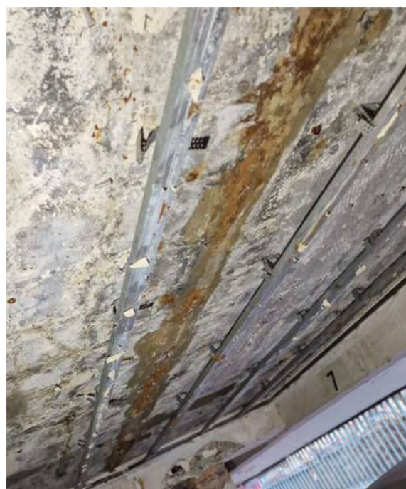
Fot. 7. Widok nalołów wodorotlenku wapnia z wybarwioną na brunatno strefą styku stropowych płyt prefabrykowanych
