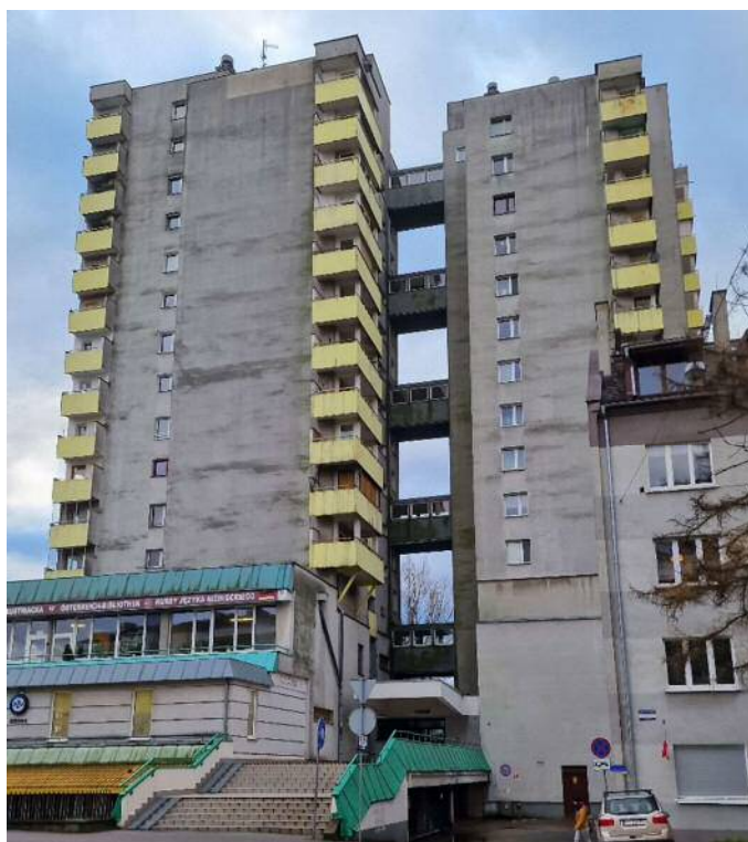
Fot. 2. Widok części wysokiej z balkonami i łącznikami między budynkami
