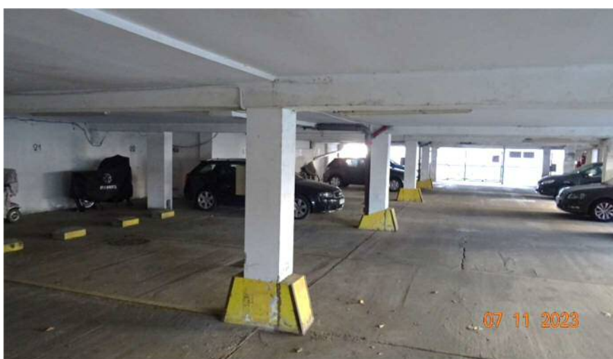
Fot. 3. Strop garażu z zastłoniętymi płytami stropowymi za pomocą płyt cementowo-włóknowych
