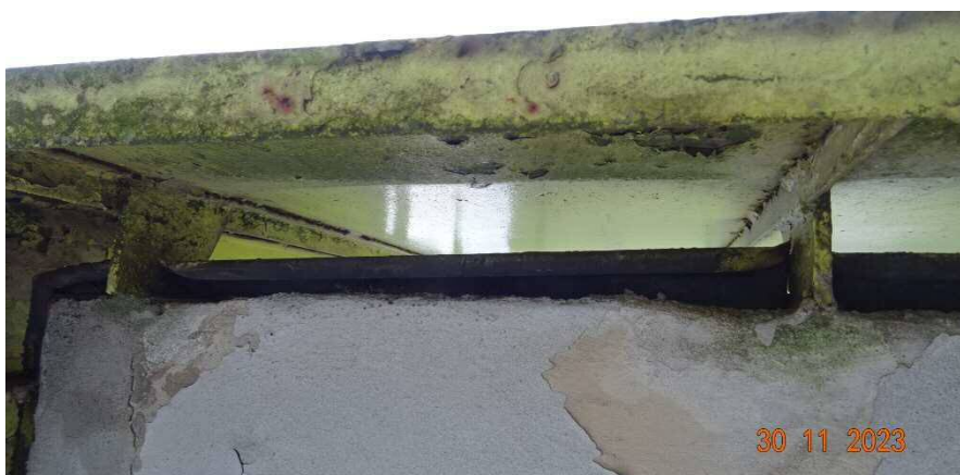
Fot. 19. Sposób montażu balustrady poprzez spawanie blach połączeniowych z markami zabetonowanymi w czole płyty balkonowej (lokal 5/12)
