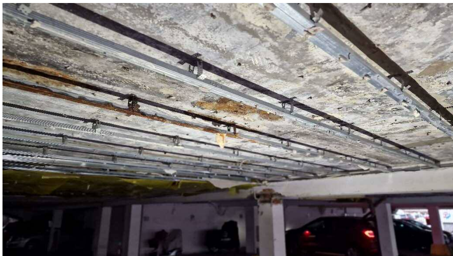
Fot. 5. Strop garażu po odsłonięciu płyt cementowo-włóknowych – widoczne profile do montażu płyt
