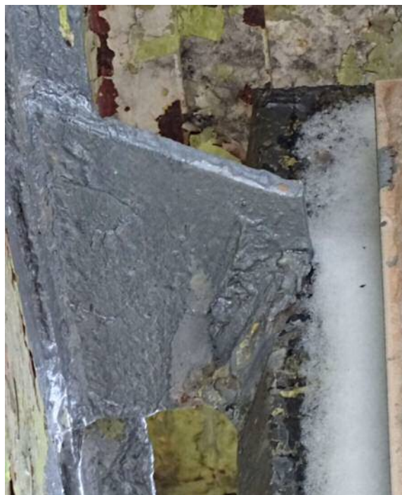
Fot. 20. Spaw blachy połączeniowej balustrady z marką płyty balkonowej, do którego wprowadzono także obróbkę blacharską (lokal 5/8)
