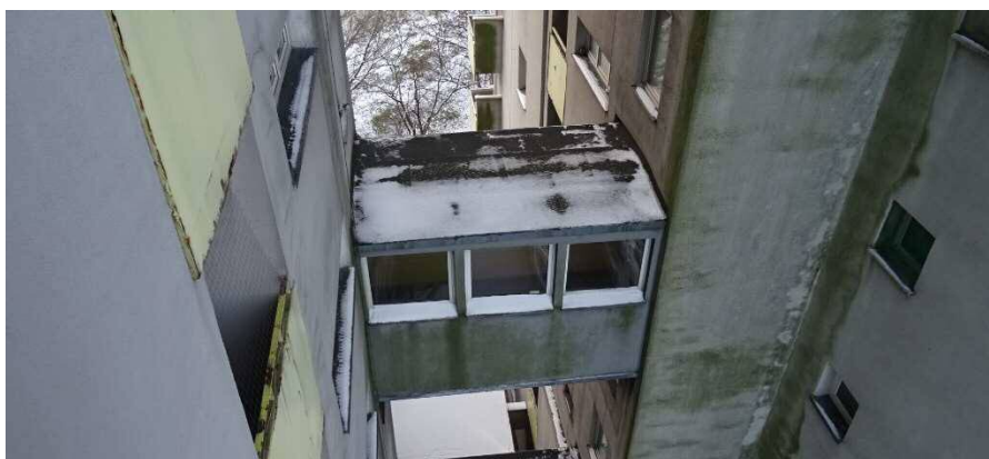
Fot. 33. Widok łącznika między budynkami – drugi od dołu
