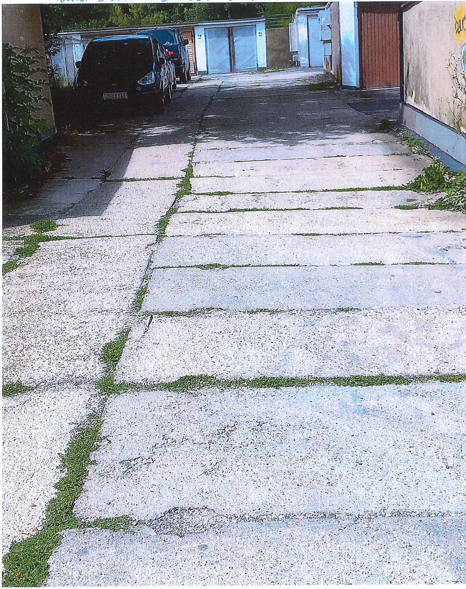
DROGA DOJAZDOWA DO SEGMENTU GARAŻY NR 60-71
